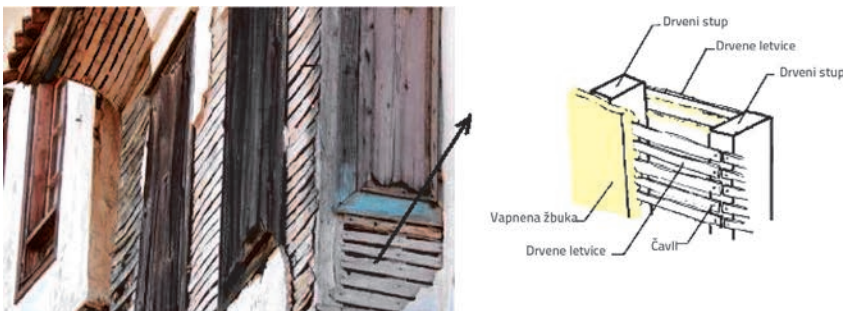
Slika 6. Izgradnja zida drvene okvirne konstrukcije prema bağdadî tehnici (Sirince, 2013.)
