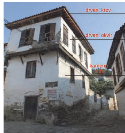
Slika 5. Konfiguracija konstrukcije tipične dvoetažne tradicijske şirinceuske kuće
